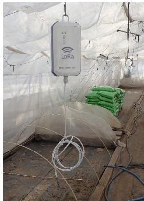
温室監視 （室温・土壌温）
